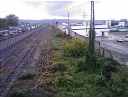
Bahngleise im Untersuchungsgebiet
