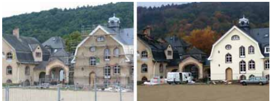
Abbildung 13 Torhaus vor der Lokrichthalle Sommer und Herbst 2008
