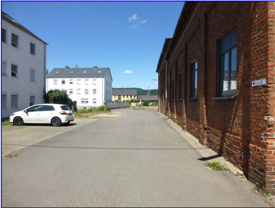
Abb. 5: Südwestfassade eines Walzwerkteils und angrenzende Wohnbebauung
