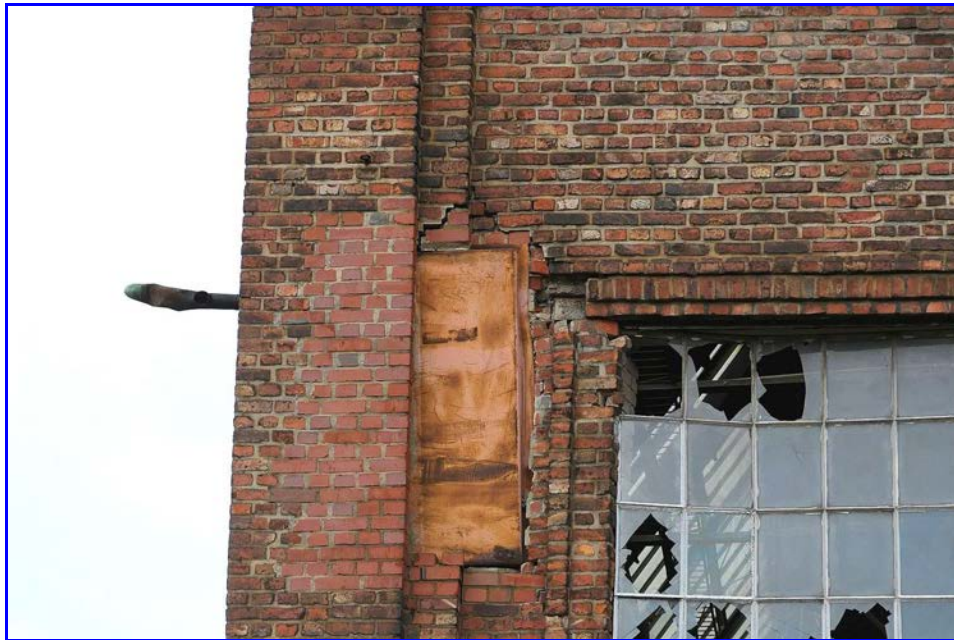
Abb. 31: Mauerrisse und -fugen an der Nordfassade
