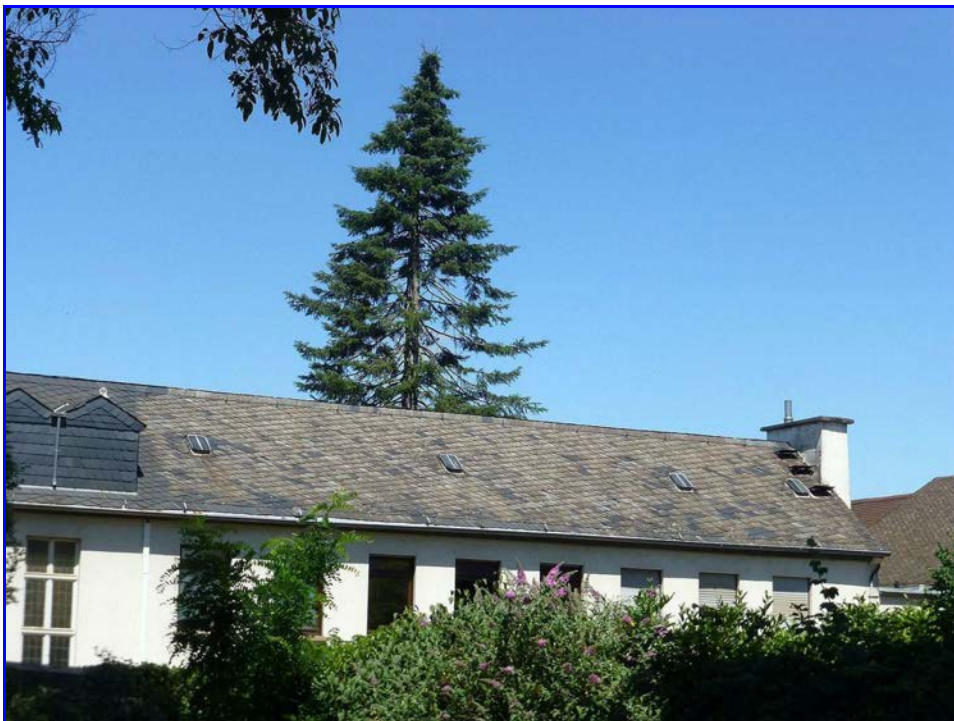
Abb. 25: Ehemaliges Verwaltungsgebäude mit Eternitdach
