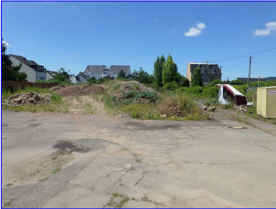
Abb. 12: Gebäudeabriss im Westteil des UG
