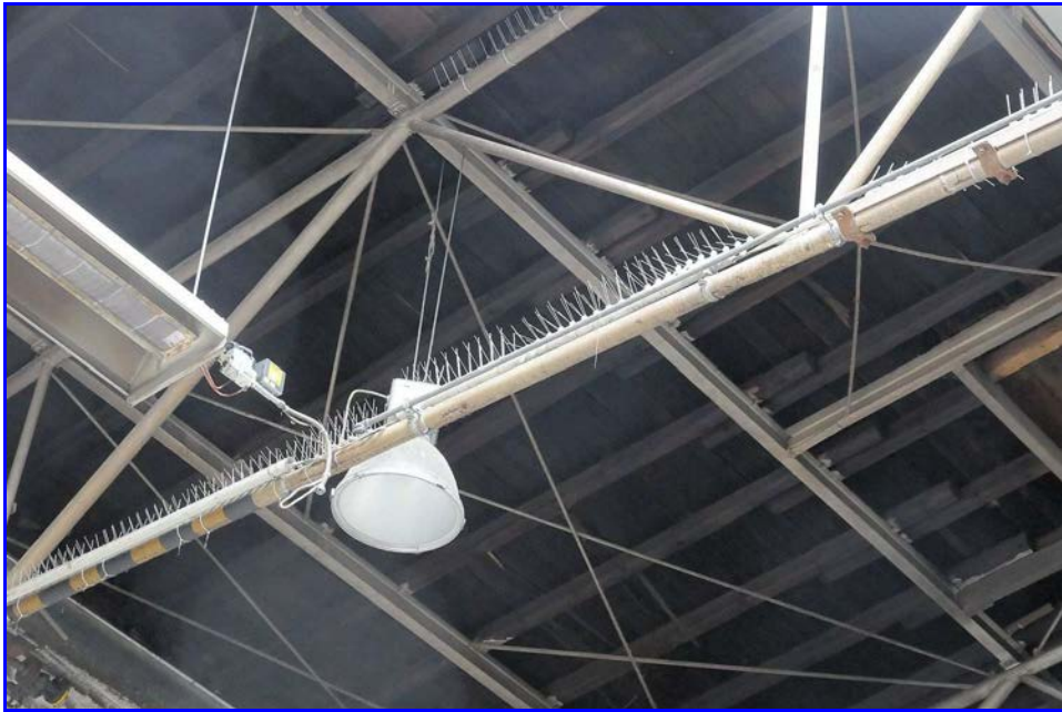
Abb. 18: Stählerne Dachkonstruktion mit Deckenstrahlern und Nagelleisten zur Taubenabwehr
