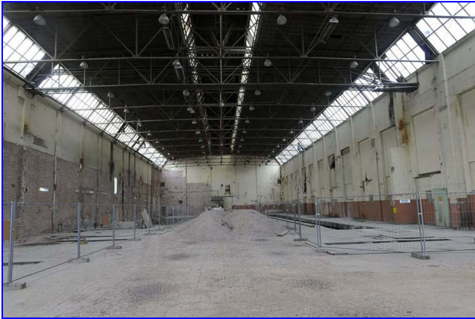
Abb. 14: Tlw. rohe Backsteinmauern, Teile gestrichen
