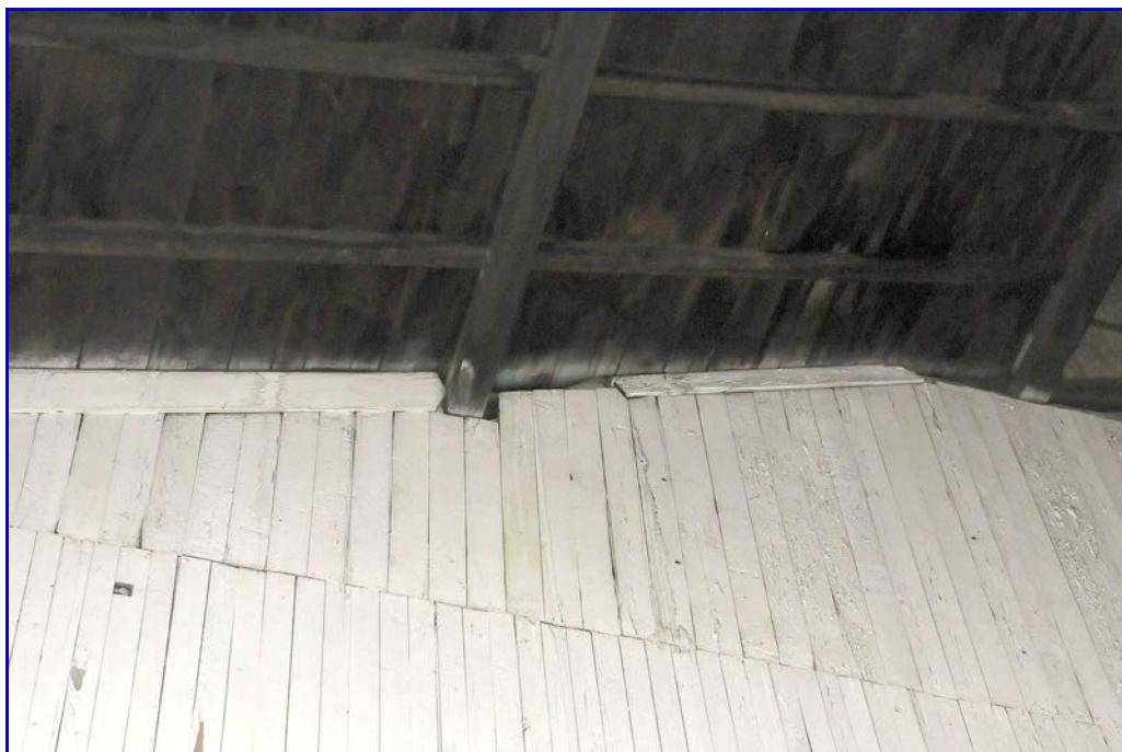
Abb. 32: Balkenauflage mit Spalten
