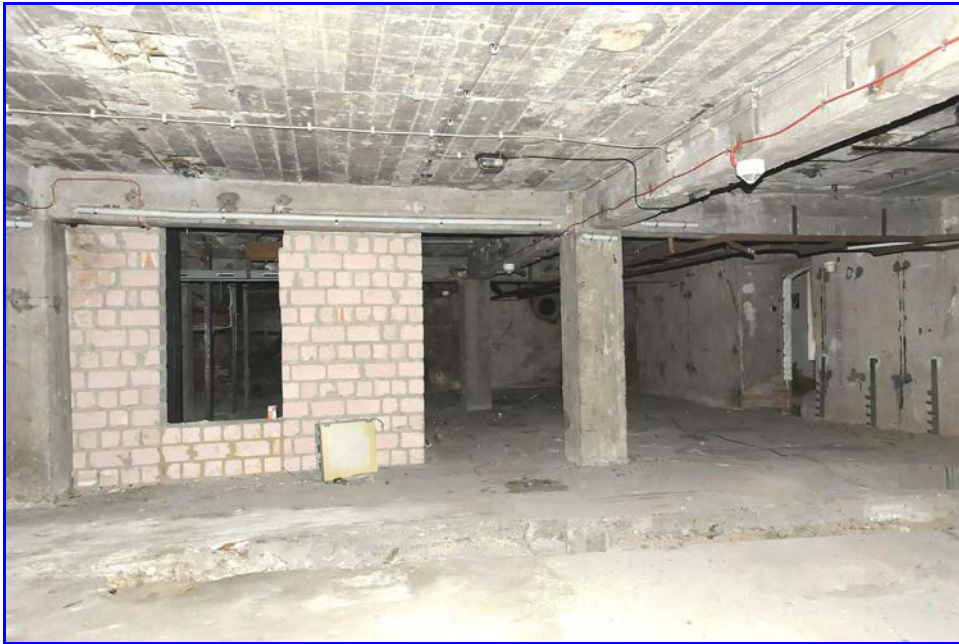
Abb. 22: Teilansicht des Kellerbereichs
