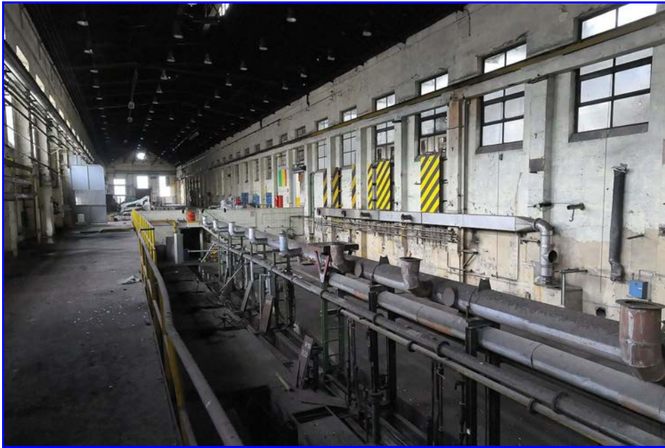
Abb. 16: Halle mit verbliebener technischer Infrastruktur
