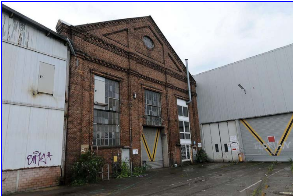
Abb. 23: Nordfront des Hallenkomplexes
