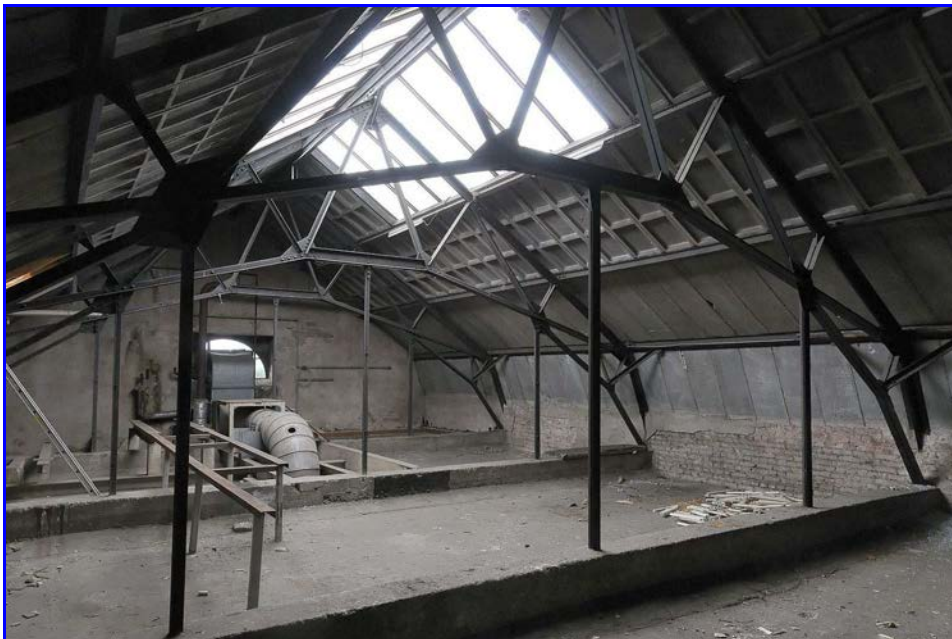
Abb. 21: Dachboden mit stählerner Dachkonstruktion
