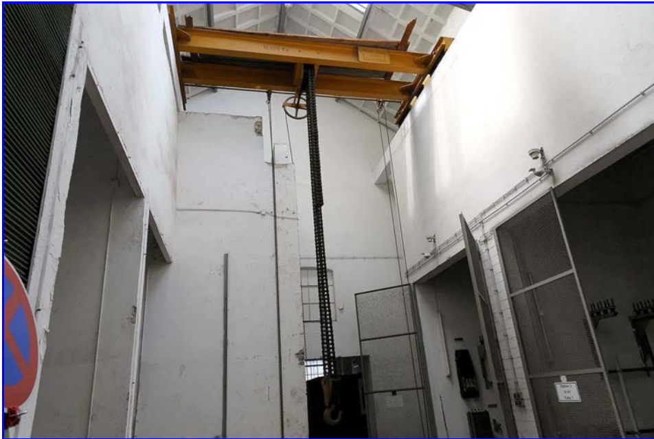
Abb. 20: Teilansicht der Kranhalle
