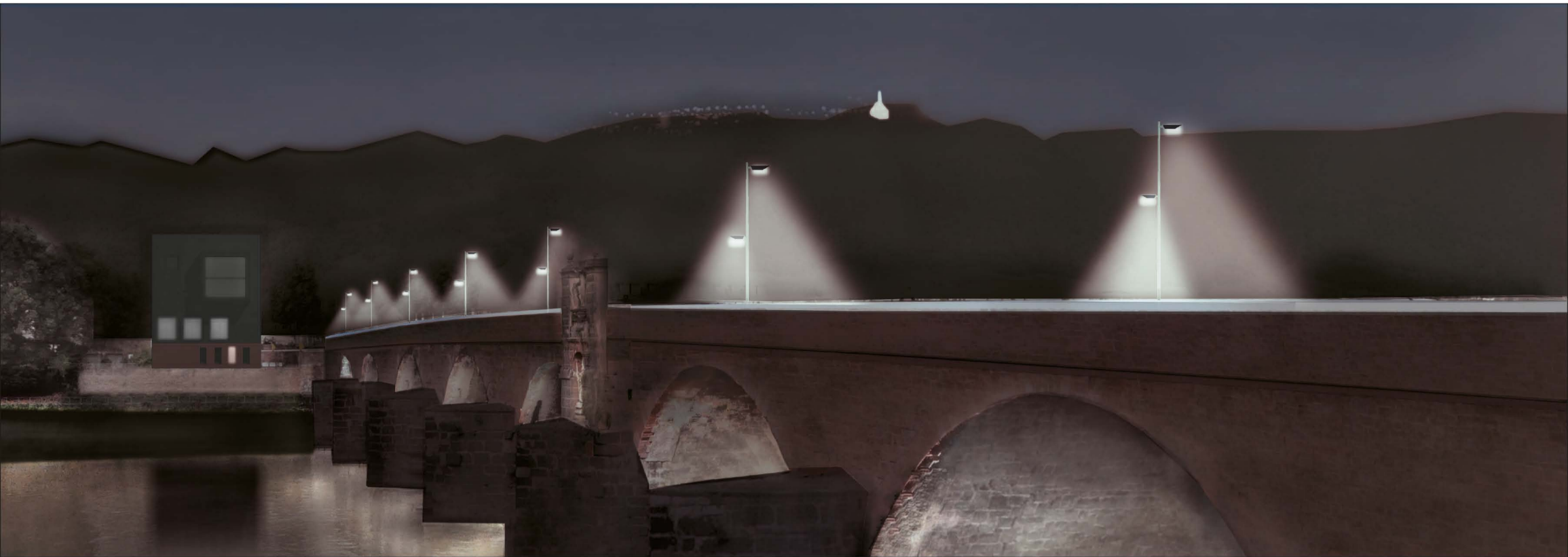
Nachtsicht Römerbrücke mit neuem westlichen Brückenkopf
