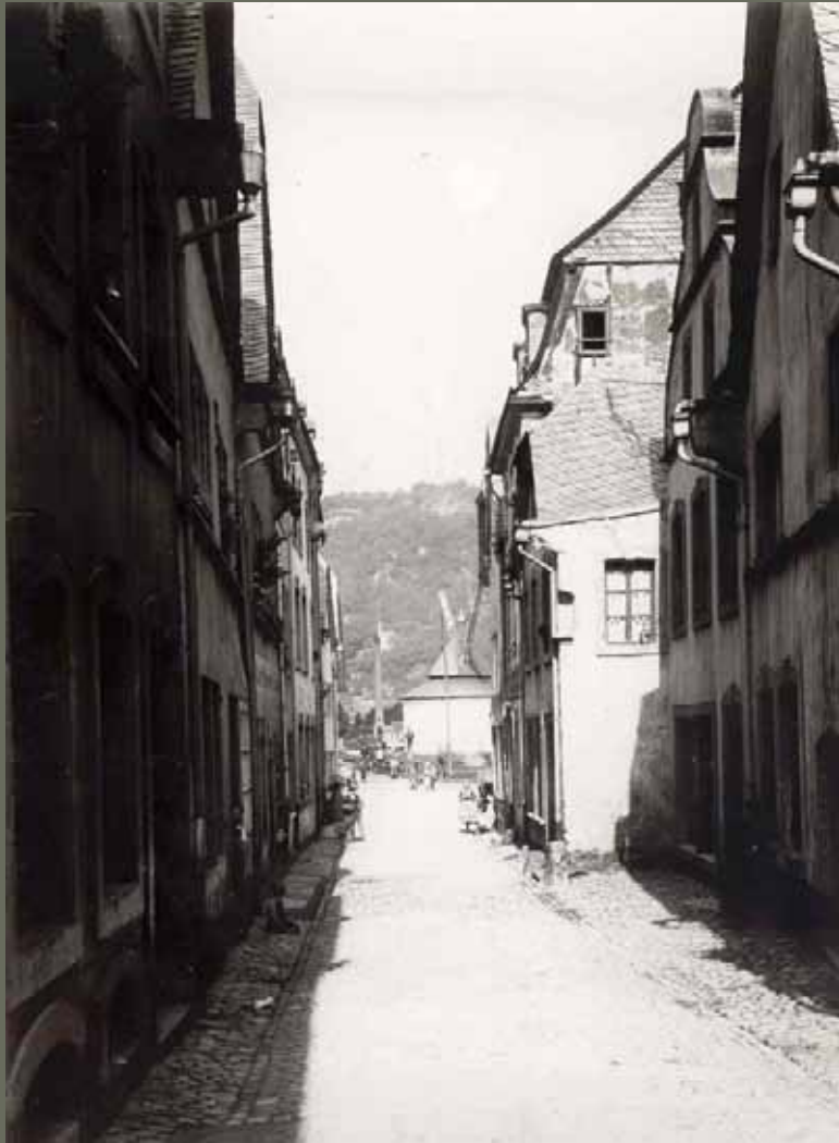
Vor Errichtung des Hochwasserschutzdamms
